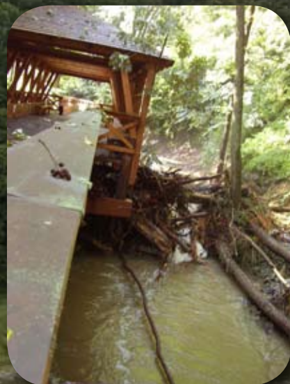
Řička Veverka při dvou červencových bouřkách poškodila řadu objektů LČR, s.p.
